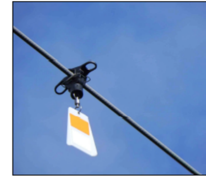
Figure 147 : Balise Firefly, considérée comme l'une des balises les plus efficaces actuellement pour réduire les collisions.
